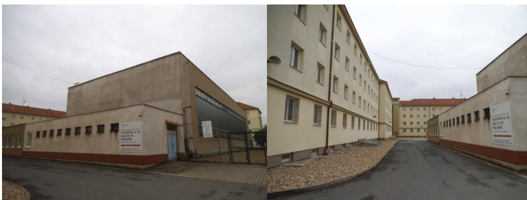
foto č. 9 a 10 – vlevo tělocvična a hřiště; vpravo d mezi ubytovacím blokem a tělocvičnou
