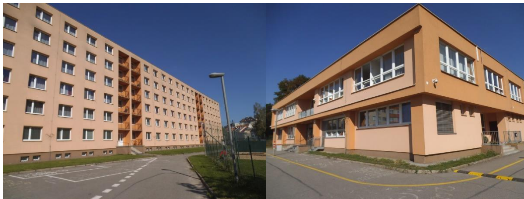
foto č. 13 a 14 – vlevo ubytovací blok D; vpravo administrativní „kostka“
