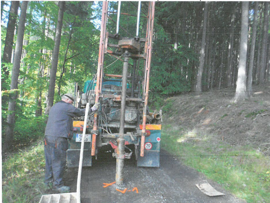
Foto 1 - V-1, st. 0,400 km L, vrtání soupravou UGB (Ø 156 mm)
