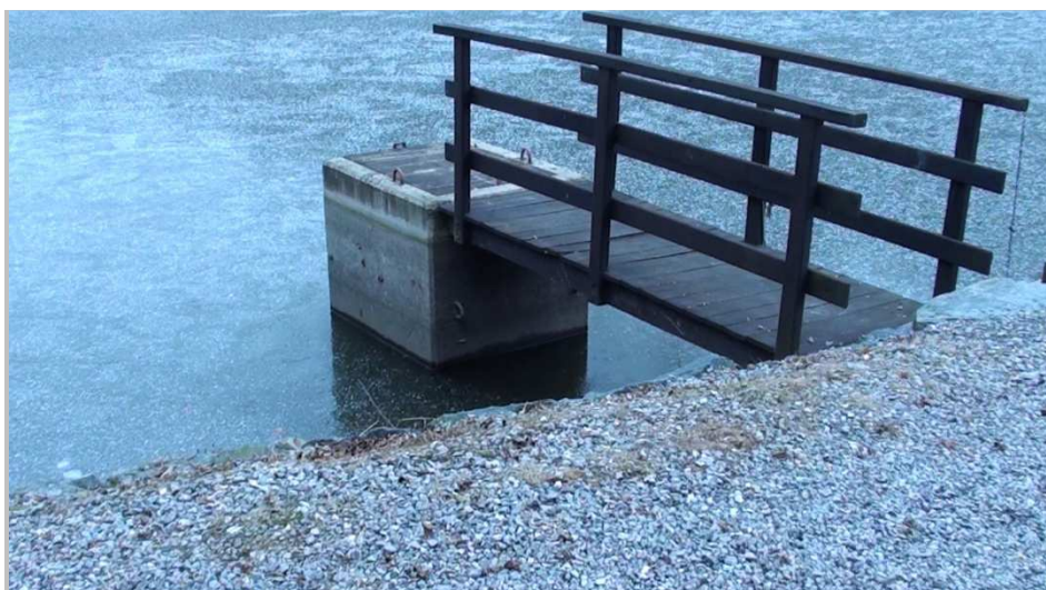
Požeráková výpust – demontáž lávky, odstranění betonového základu lávky
