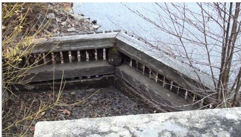
Pohled na stávající dřevěné česle bezpečnostního přelivu
