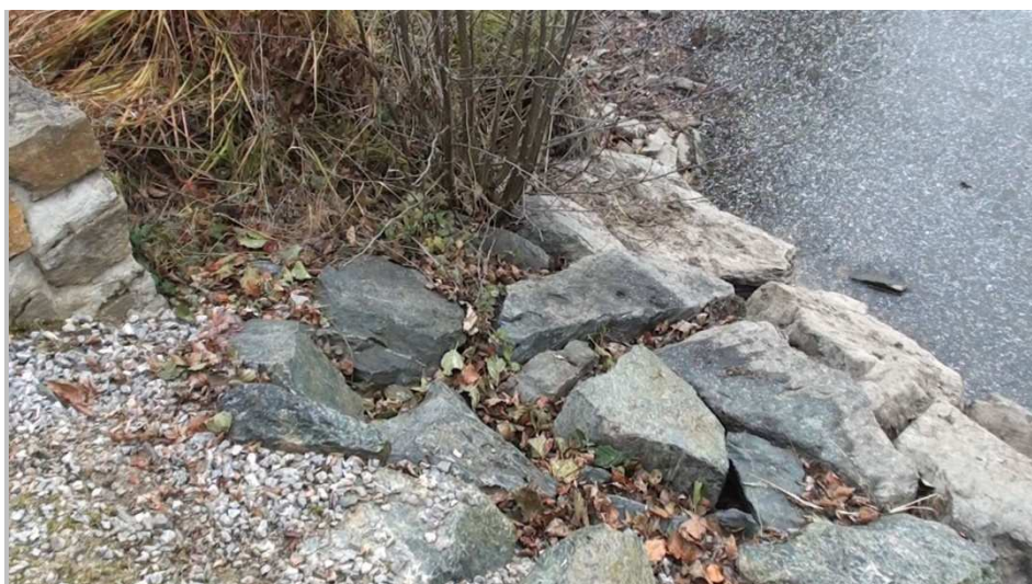
Kamenná rovníanina v místě napojení na bezpečnostní přeliv – rozebrání, doplnění
