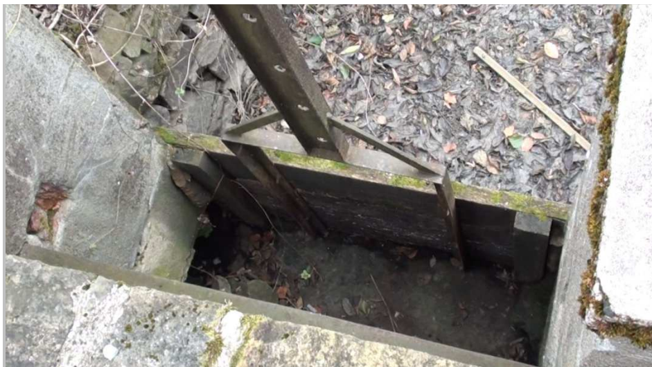
Stávající hrazení bezpečnostního objektu, podemílané betonové pilíře
