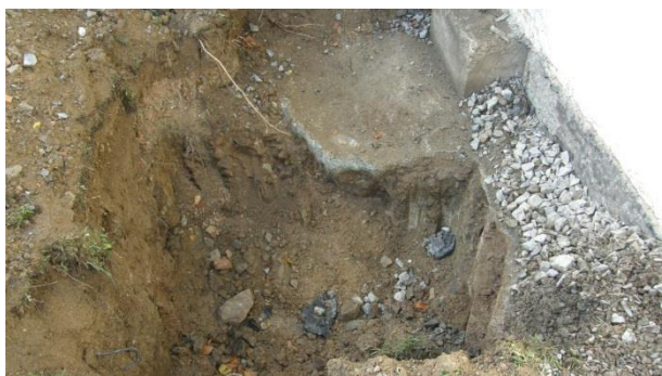
Obr. 7. Kopaná sonda u základu.
