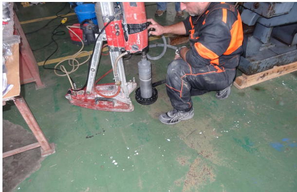
Obr. 5. Vývrt pro zjištění skladby podlahy.
