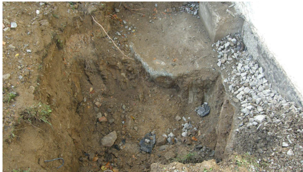
Obr. 9. Kopaná sonda u základu.
