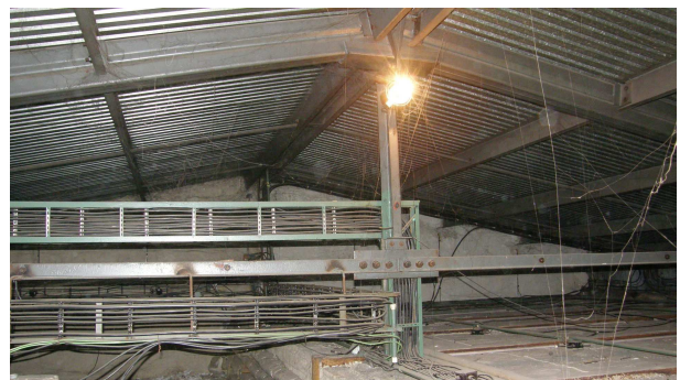
Obr. 8. Podstřešní prostor objektu.
