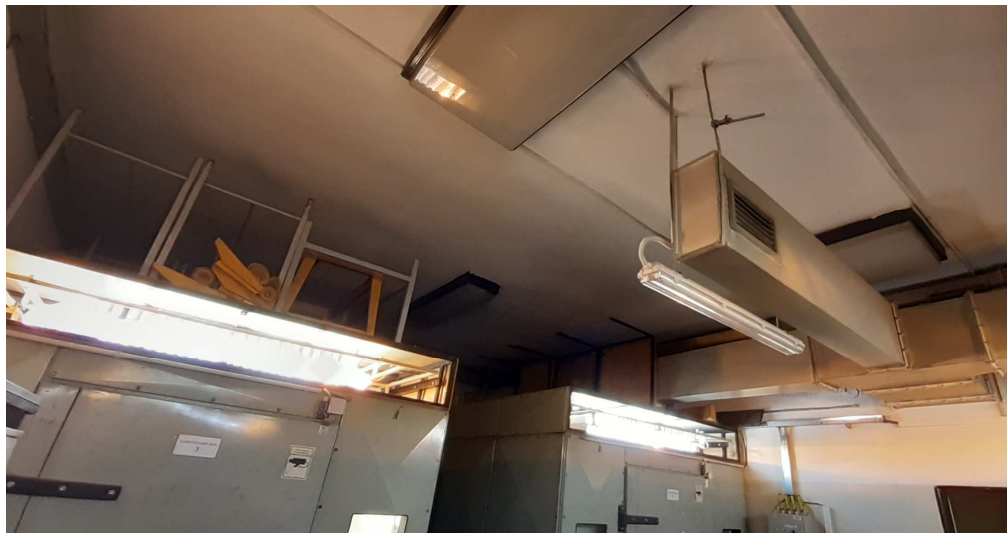
Obr.3 – pohled na odbočku stávající VZT, nad ní umístit textilní výúst'
