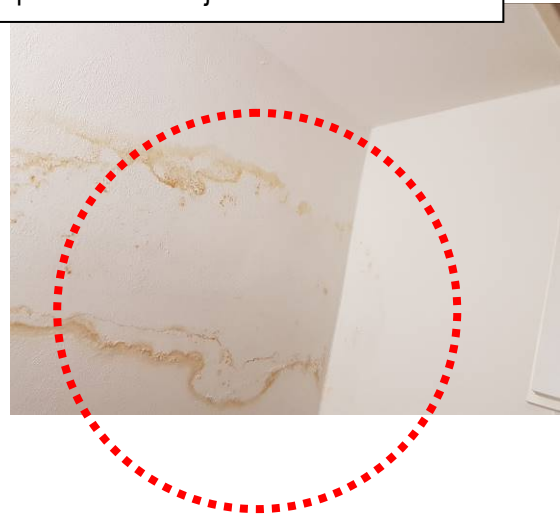
Stav stropních konstrukcí pod střechou objektu SO 03
