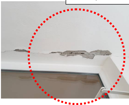
Stav stropních konstrukcí pod střechou objektu SO 03
