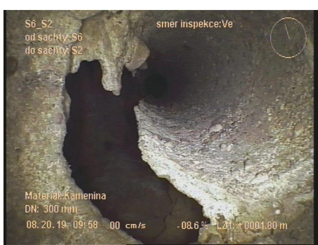
Š6_Š2: Prasklina v potrubí/zřícení, dl. 150 mm
