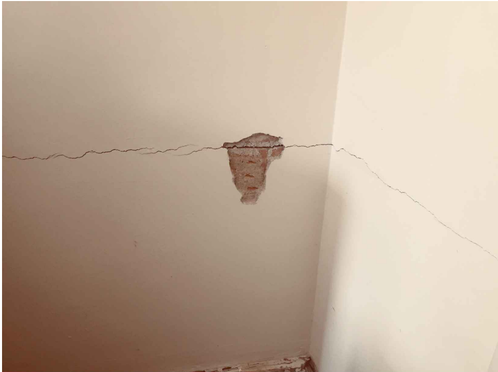
PRASKLINA PROBÍHAJÍCÍ VE ZDIVU
