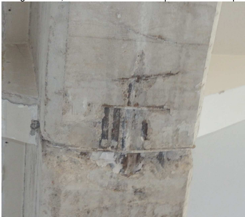
Fotografie č. 4,5 – nezhučněné oblasti spodních líců stropních rámu
