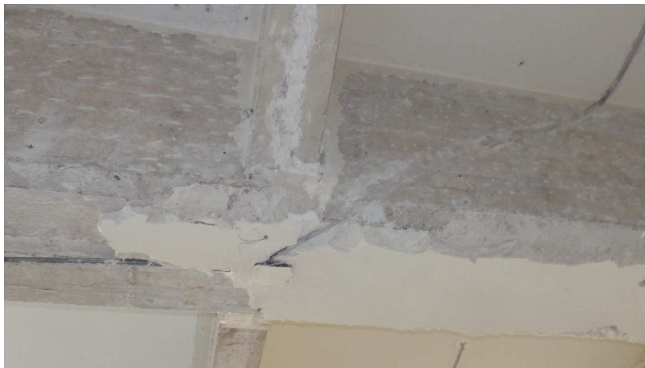
Fotografie 11 – stávající překlady nad otvorem
