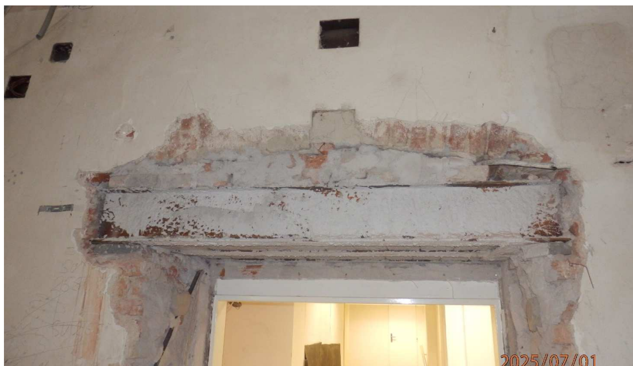
Fotografie 11 – stávající překlady nad otvorem
