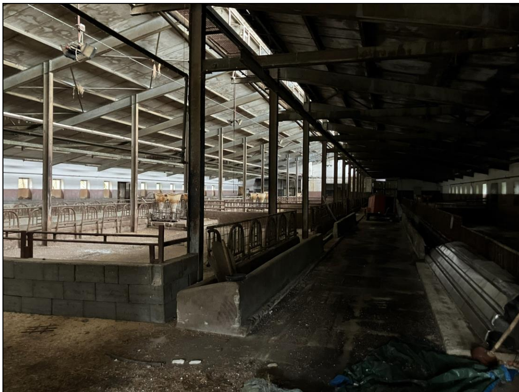
Obr. č. 23 Interiér haly (prostor haly) zemědělského areálu na pozemku p. č. 1560/21, k. ú. Lednice na Moravě [zdroj: vlastní; místní šetření ze dne 9. 10. 2025]
