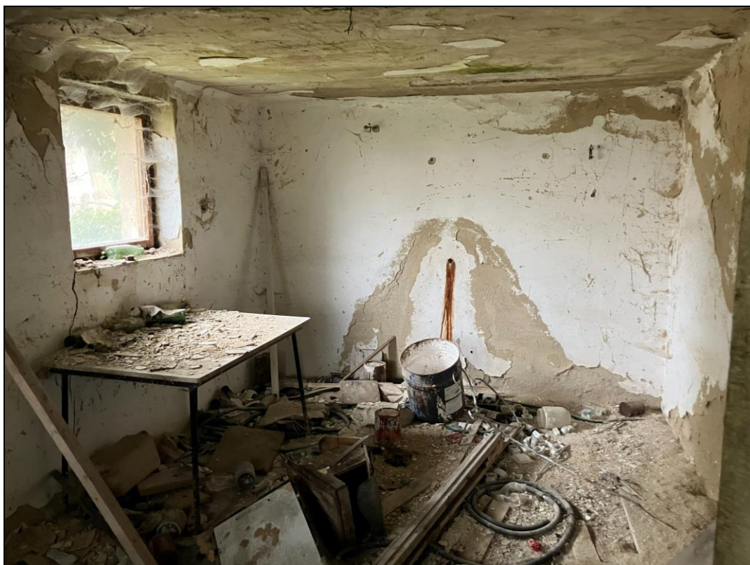
Obr. č. 45 Interiér stavby zemědělského areálu na pozemku p. č. 1560/35, k. ú. Lednice na Moravě [zdroj: vlastní; místní šetření ze dne 9. 10. 2025]
