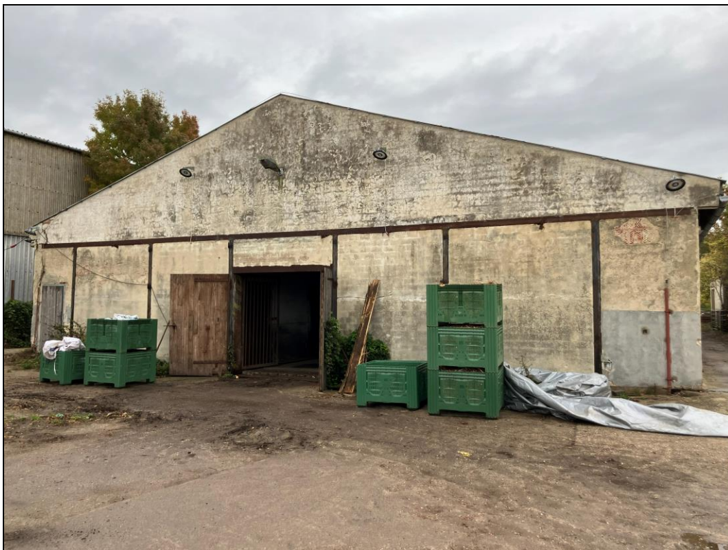
Obr. č. 9 Západní pohled na halu zemědělského areálu na pozemku p. č. 1557/2, k. ú. Lednice na Moravě [zdroj: vlastní; místní šetření ze dne 9. 10. 2025]
