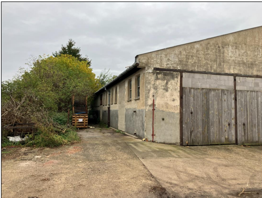
Obr. č. 5 Severní pohled na halu zemědělského areálu na pozemku p. č. 1558/2, k. ú. Lednice na Moravě [zdroj: vlastní; místní šetření ze dne 9. 10. 2025]
