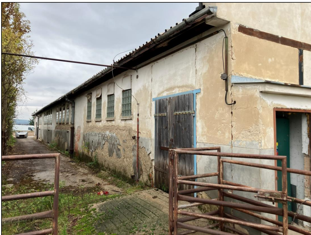
Obr. č. 8 Jižní pohled na halu zemědělského areálu na pozemku p. č. 1557/2, k. ú. Lednice na Moravě [zdroj: vlastní; místní šetření ze dne 9. 10. 2025]
