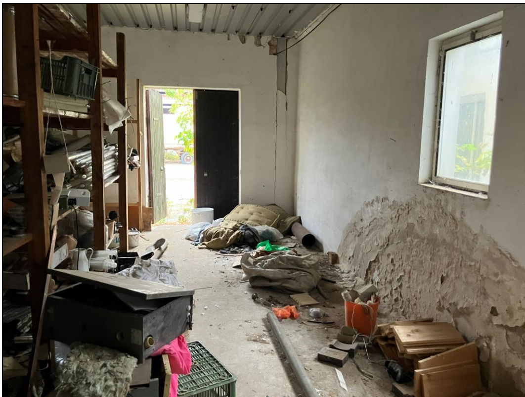
Obr. č. 28 Interiér stavby administrativy zemědělského areálu na pozemku p. č. 1560/21, k. ú. Lednice na Moravě [zdroj: vlastní; místní šetření ze dne 9. 10. 2025]
