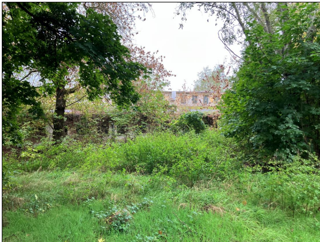
Obr. č. 37 Severovýchodní pohled na halu zemědělského areálu na pozemku p. č. 1549/5, k. ú. Lednice na Moravě [zdroj: vlastní; místní šetření ze dne 9. 10. 2025]
