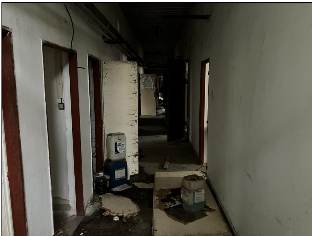
Obr. č. 26 Interiér stavby administrativy zemědělského areálu na pozemku p. č. 1560/21, k. ú. Lednice na Moravě [zdroj: vlastní; místní šetření ze dne 9. 10. 2025]
