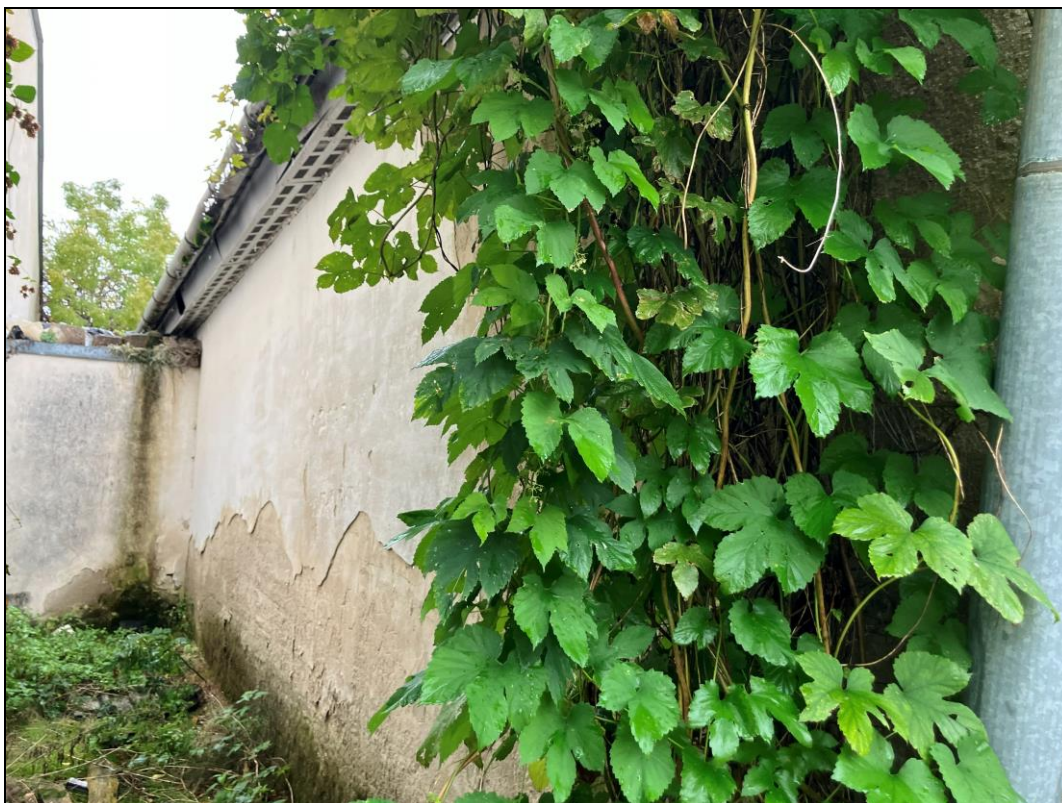
Obr. č. 22 Severozápadní pohled na halu zemědělského areálu na pozemku p. č. 1560/21, k. ú. Lednice na Moravě [zdroj: vlastní; místní šetření ze dne 9. 10. 2025]
