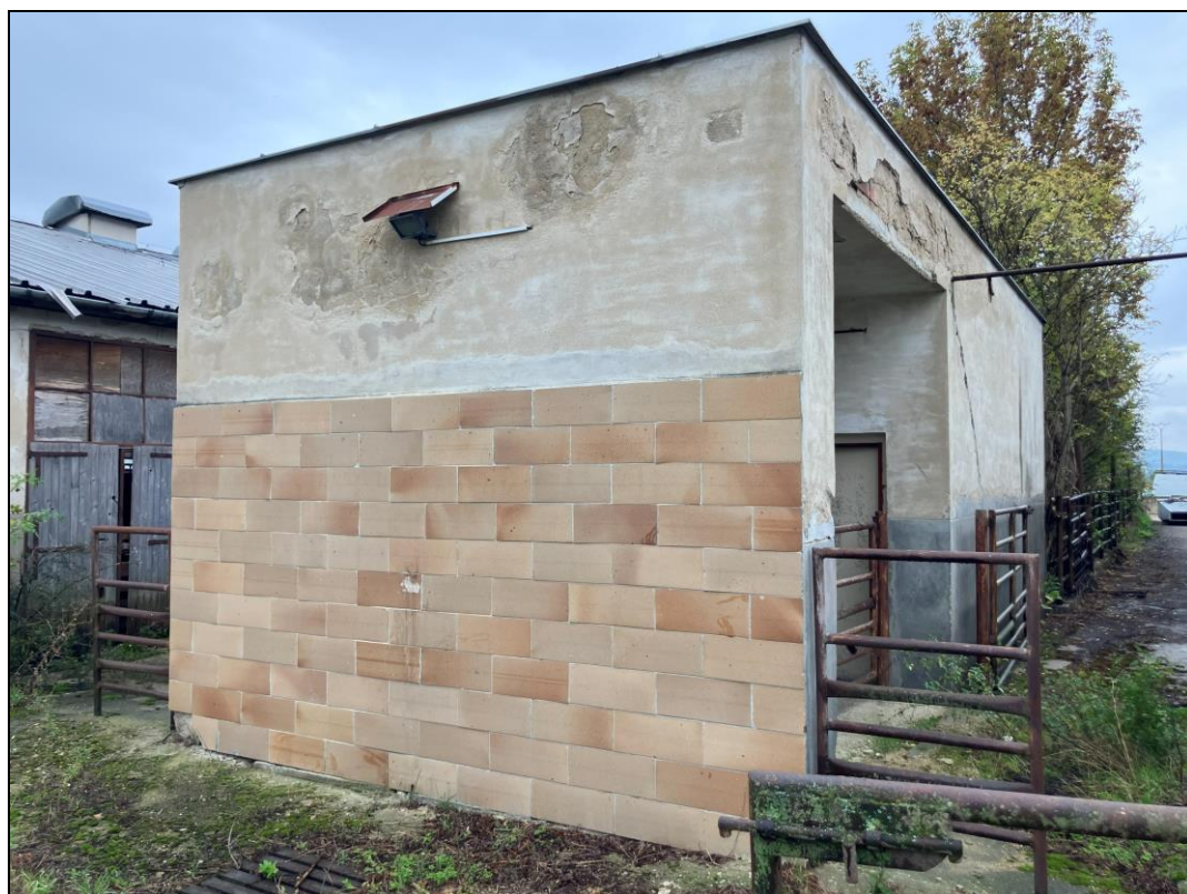
Obr. č. 46 Východní pohled na stavbu vážního domku zemědělského areálu na pozemku p. č. 1560/44, k. ú. Lednice na Moravě [zdroj: vlastní; místní šetření ze dne 9. 10. 2025]
