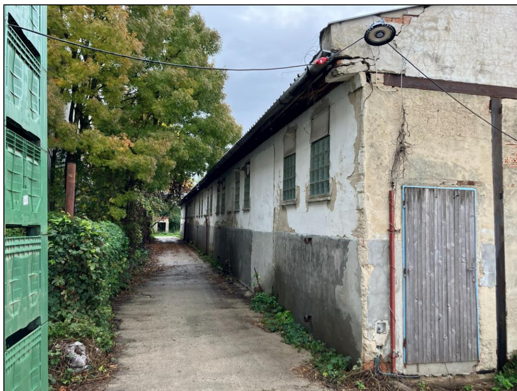
Obr. č. 10 Severozápadní pohled na halu zemědělského areálu na pozemku p. č. 1557/2, k. ú. Lednice na Moravě [zdroj: vlastní; místní šetření ze dne 9. 10. 2025]
