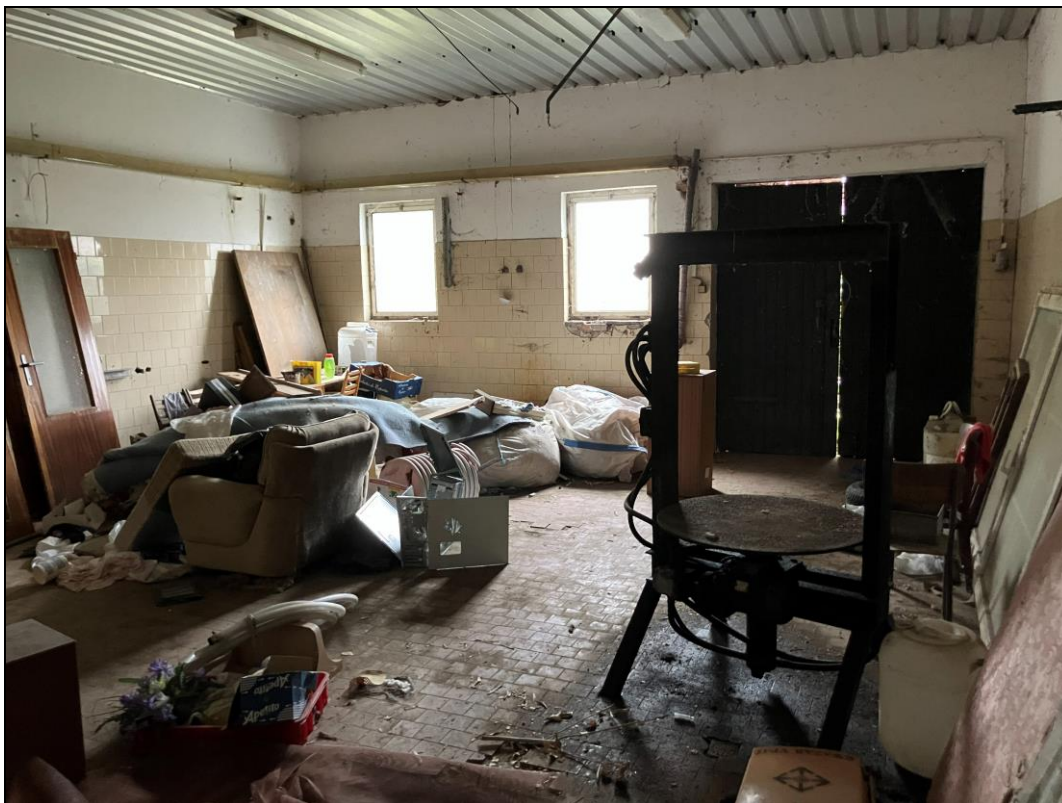
Obr. č. 27 Interiér stavby administrativy zemědělského areálu na pozemku p. č. 1560/21, k. ú. Lednice na Moravě [zdroj: vlastní; místní šetření ze dne 9. 10. 2025]
