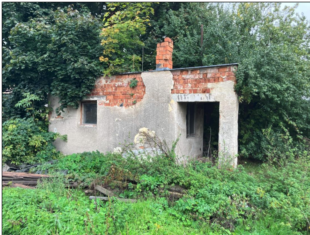
Obr. č. 41 Severozápadní pohled na stavbu zemědělského areálu na pozemku p. č. 1560/35, k. ú. Lednice na Moravě [zdroj: vlastní; místní šetření ze dne 9. 10. 2025]
