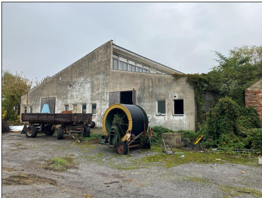
Obr. č. 20 Západní pohled na halu zemědělského areálu na pozemku p. č. 1560/21, k. ú. Lednice na Moravě [zdroj: vlastní; místní šetření ze dne 9. 10. 2025]
