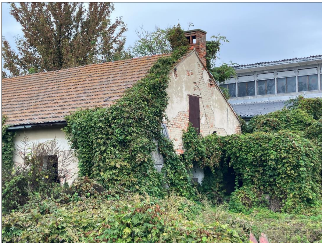
Obr. č. 16 Jižní pohled na halu zemědělského areálu na pozemku p. č. 1553, k. ú. Lednice na Moravě [zdroj: vlastní; místní šetření ze dne 9. 10. 2025]
