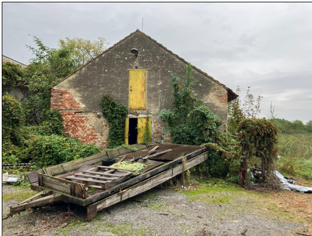
Obr. č. 13 Severozápadní pohled na halu zemědělského areálu na pozemku p. č. 1553, k. ú. Lednice na Moravě [zdroj: vlastní; místní šetření ze dne 9. 10. 2025]
