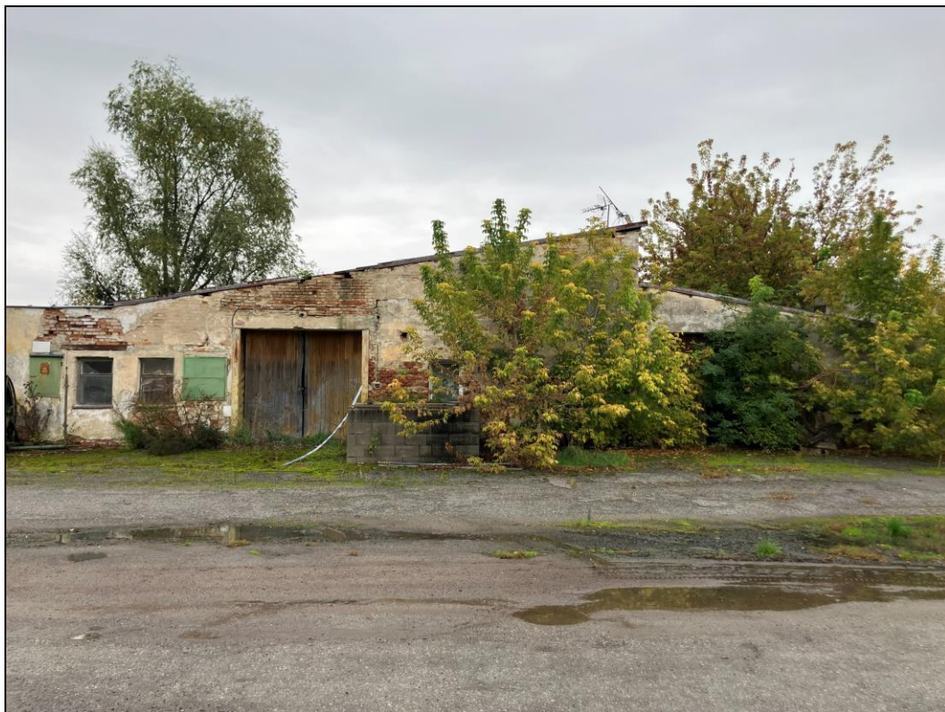
Obr. č. 29 Severozápadní pohled na halu zemědělského areálu na pozemku p. č. 1549/4, k. ú. Lednice na Moravě [zdroj: vlastní; místní šetření ze dne 9. 10. 2025]
