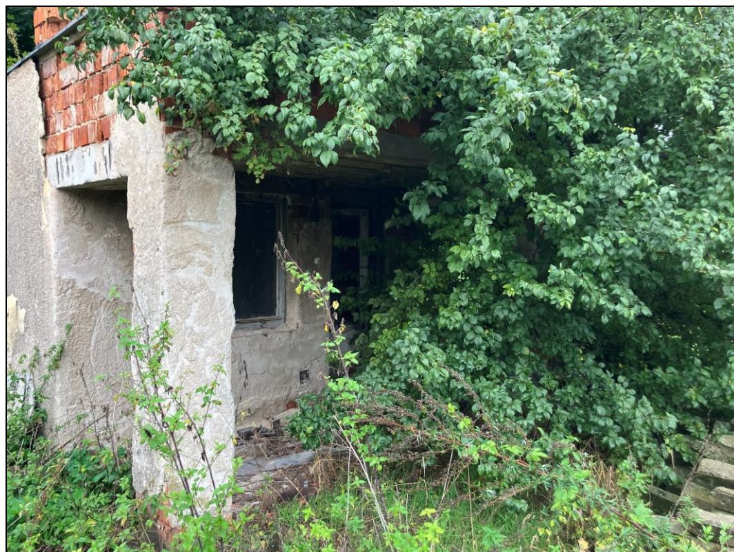
Obr. č. 42 Západní pohled na stavbu zemědělského areálu na pozemku p. č. 1560/35, k. ú. Lednice na Moravě [zdroj: vlastní; místní šetření ze dne 9. 10. 2025]
