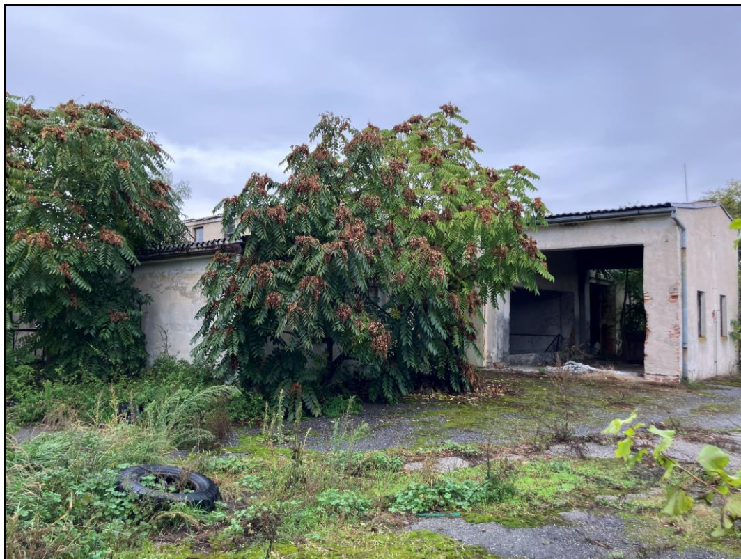
Obr. č. 31 Jižní pohled na halu zemědělského areálu na pozemku p. č. 1549/4, k. ú. Lednice na Moravě [zdroj: vlastní; místní šetření ze dne 9. 10. 2025]
