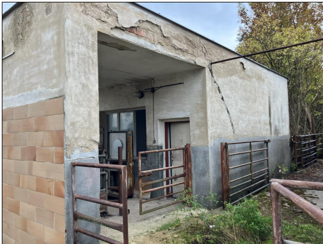
Obr. č. 47 Východní pohled na stavbu vážního domku zemědělského areálu na pozemku p. č. 1560/44, k. ú. Lednice na Moravě [zdroj: vlastní; místní šetření ze dne 9. 10. 2025]
