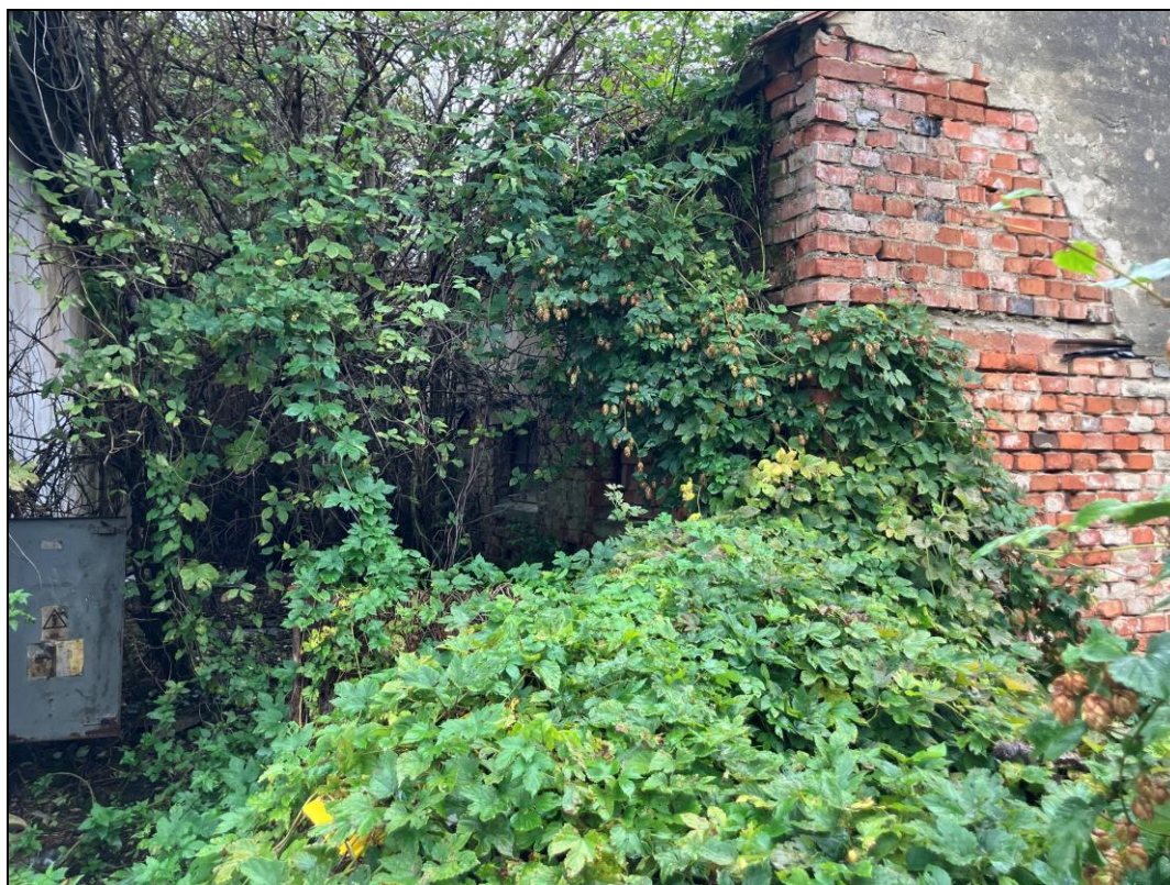
Obr. č. 14 Severní pohled na halu zemědělského areálu na pozemku p. č. 1553, k. ú. Lednice na Moravě [zdroj: vlastní; místní šetření ze dne 9. 10. 2025]
