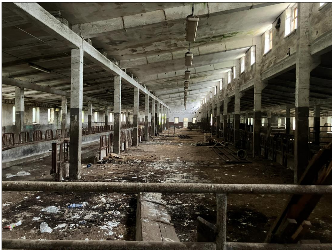
Obr. č. 33 Interiér haly (prostor haly) zemědělského areálu na pozemku p. č. 1549/4, k. ú. Lednice na Moravě [zdroj: vlastní; místní šetření ze dne 9. 10. 2025]
