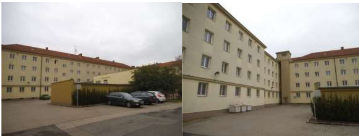
Fotografie 17, 18: Ubytovací bloky Tauferových kolejí
