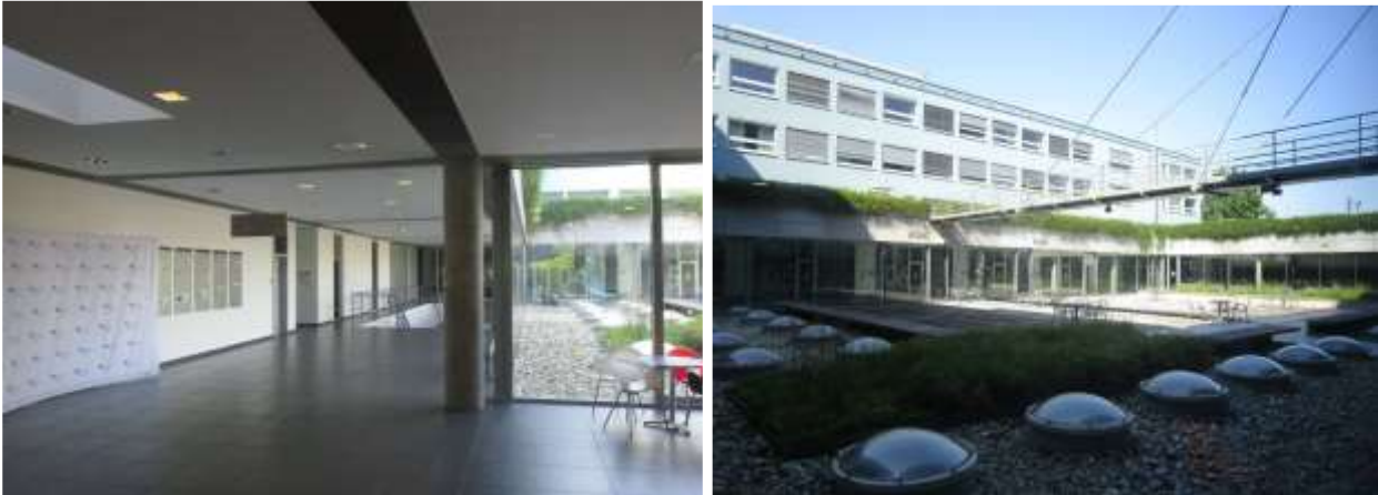
Fotografie 37, 38: Budova Q – hlavní požární komplex
