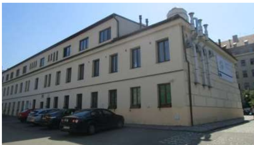
Fotografie 49: Zemědělská 1665/1, 613 00 Brno – Budova D
