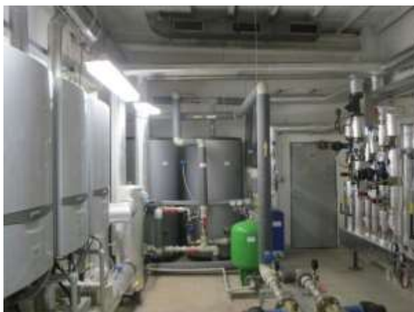
Fotografie 31: Rekonstruovaná plynová kotelna v ubytovacím bloku C
