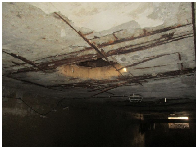
foto/3/ Pohled na zdegradovanou krycí betonovou vrstvu a žebírkovou výztuž v místě kruhového prostupu
