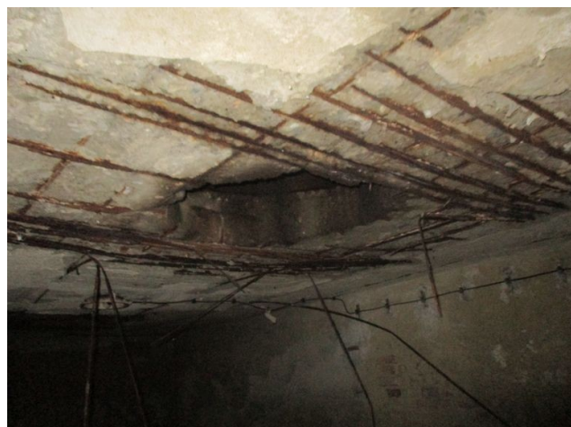
foto/4/ Pohled na zdegradovanou krycí betonovou vrstvu a žebírkovou výztuž v místě kruhového prostupu
