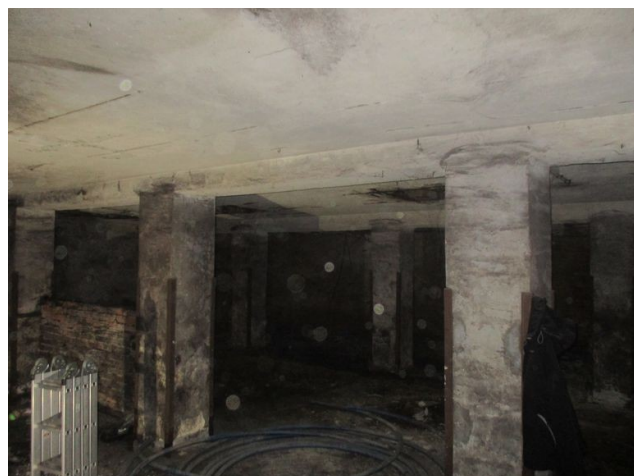
foto/2/ Pohled na železobetonový průvlak a zděné sloupy
