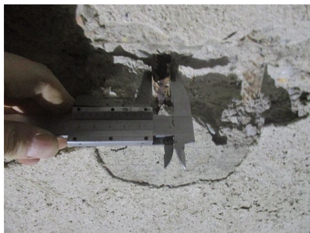
foto/8/ Pohled na průměr příčné výztuže – 14 mm
