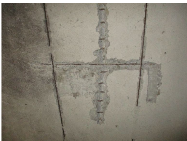
foto/5/ Pohled na provedenou sondu
