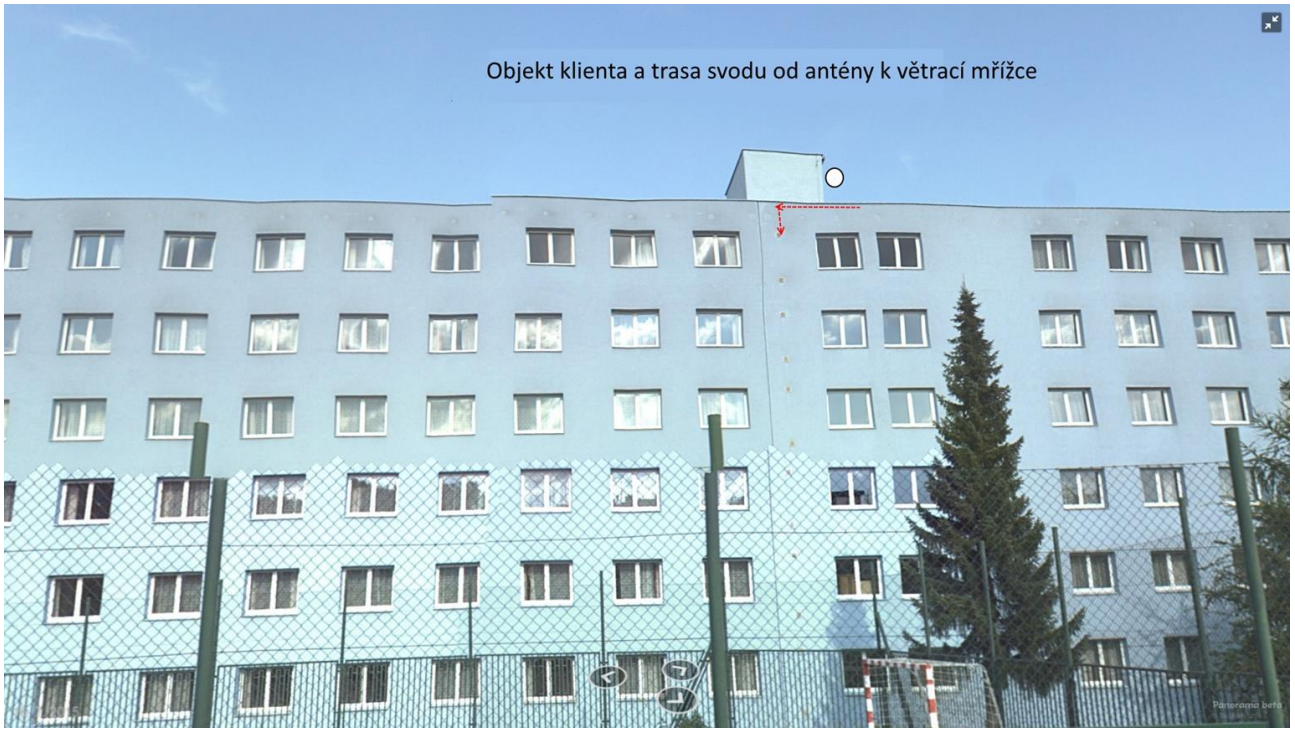
Umístění držáku s anténou a trasa svodu po střeše k prostupu do objektu
