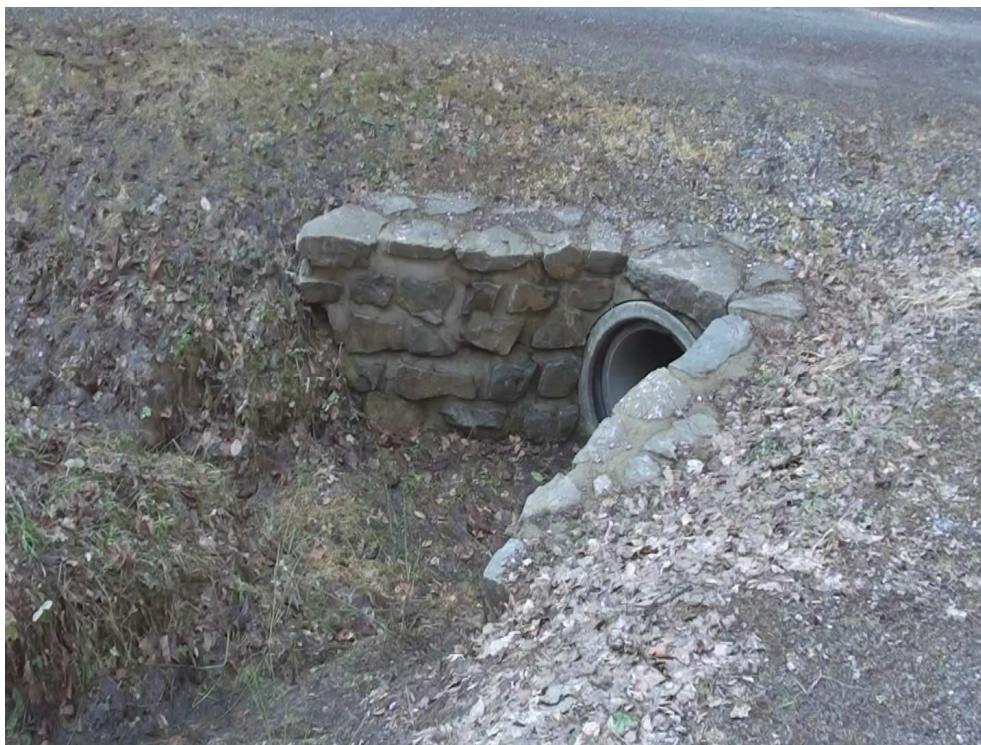
Trubní propustek v km 0,707
